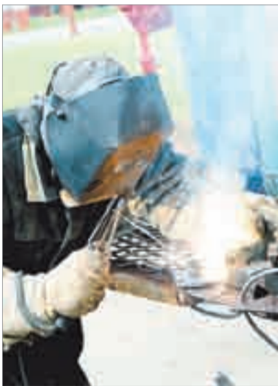
Сварку ведет старейший сварщик ООО «Причал» Марат Сахапов.
