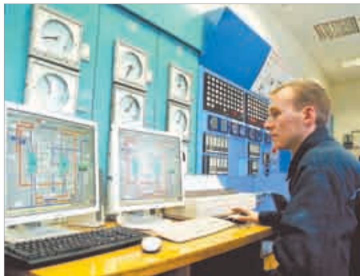
Слесарь КИПиА Андрей Носов за центральным компьютером автоматизированной системы управления производительностью и защитой магистральных компрессоров.
