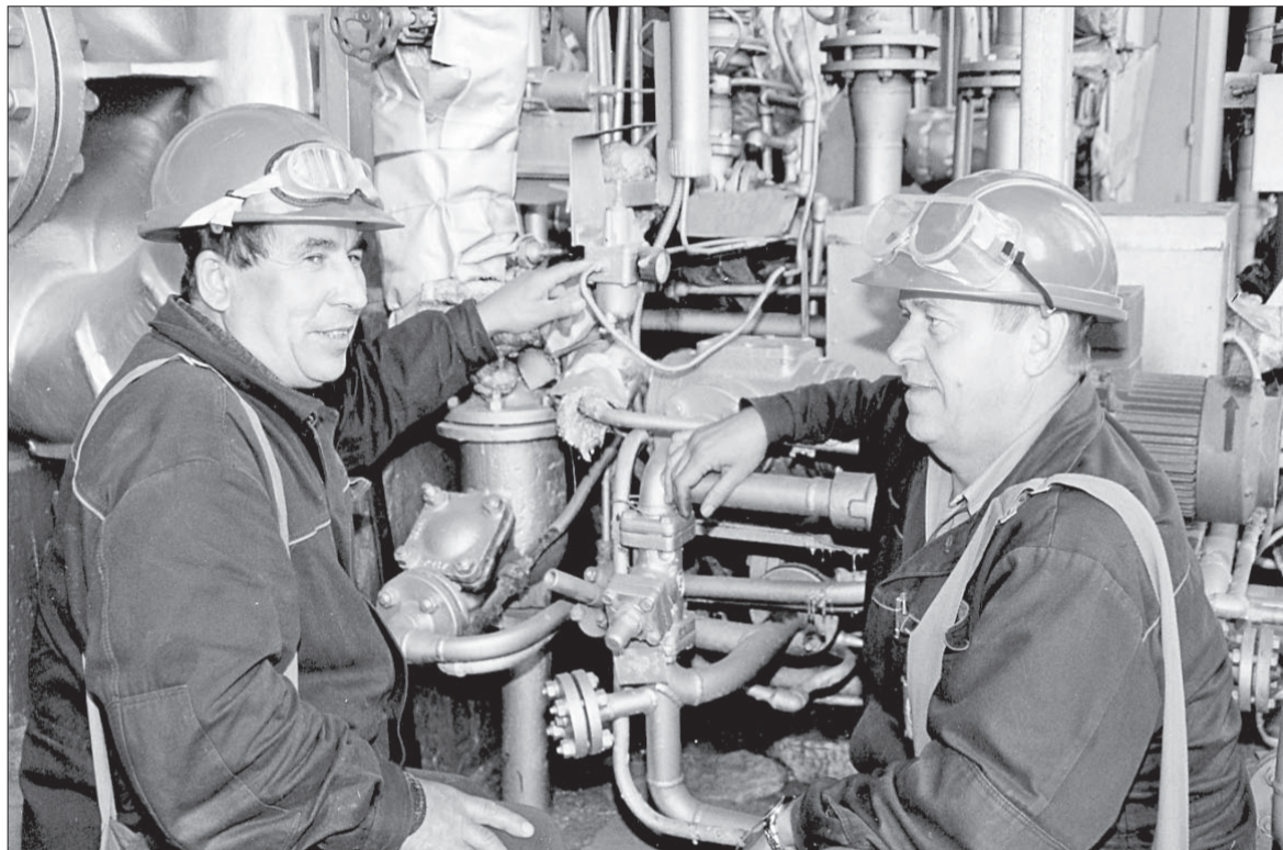
Машинисты компрессорных установок А.Галеев и П.Сконов за регулировкой маслосистемы компрессора.
