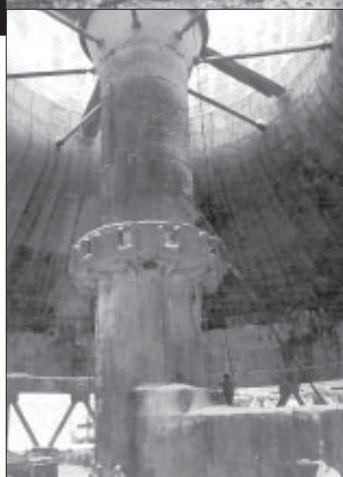
Вид градирни после демонтажа деревянных конструкций
