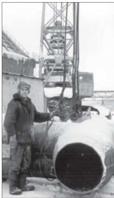
Бригадир уч. № 2 СРСУ-5 С.Чугунов готовится к монтажу водоотвода нижнего коллектора градирни
