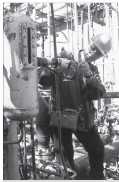
Специалист КИП Центромонтажавтоматики на монтаже приборов КИПиА.
